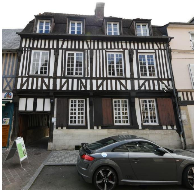
Maison à pans de bois, Pont-Audemer (27)
