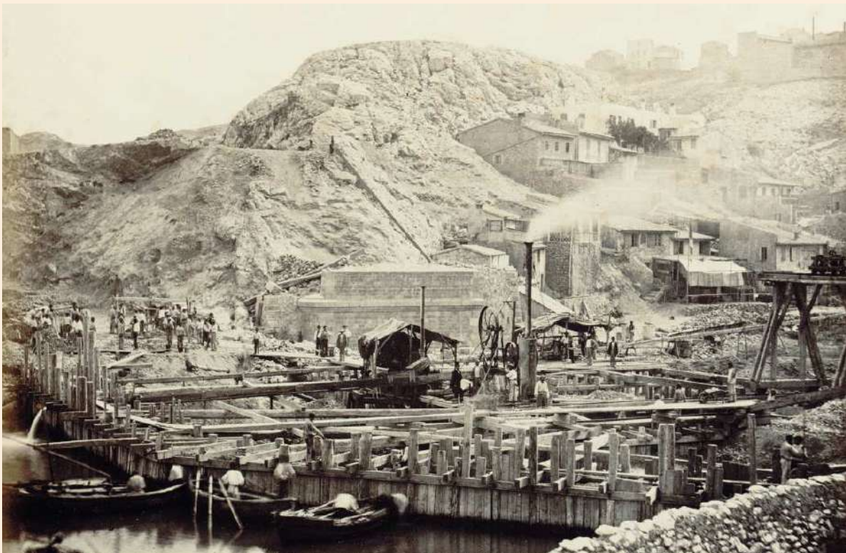
Le chantier du viaduc des Auffes. Photographie d'Adolphe Terris. © Collection privée
