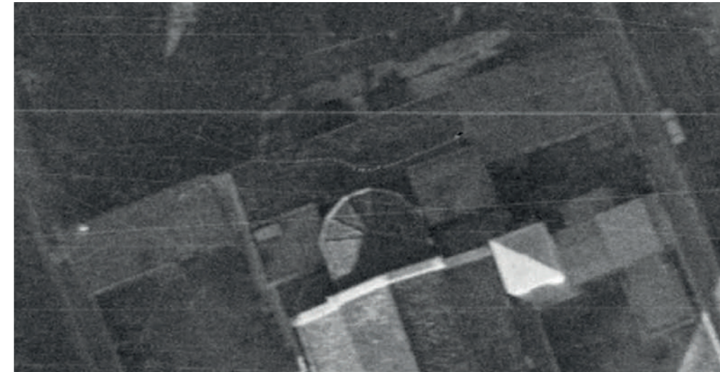
Photo aérienne de l'église St-Martin d'Arenc en 1960 - le presbytère et annexe sont encore intacts au niveau du chevet, on observe aussi une construction contre le clocher
